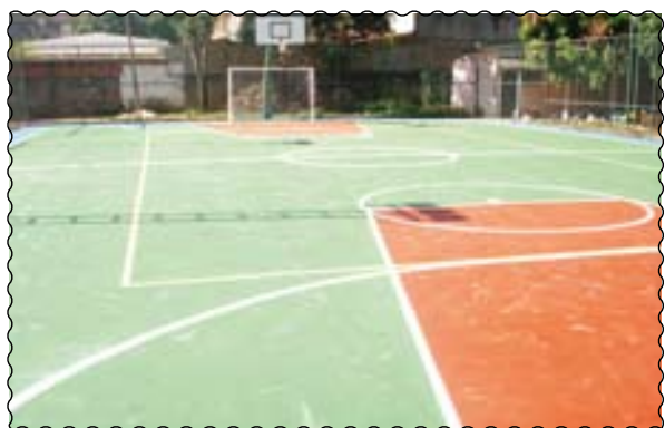
Reforma da quadra poliesportiva com recuperação e pintura do piso e arquibancadas...
